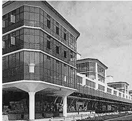
Owen Williams, architecte, manufacture de chaussures à Beeston, Grande-Bretagne, 1932.
