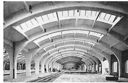
Heinrich Zieger, architecte, Wayss et Freitag, constructeurs, usine de produits émaillés à Ligetfalu, 1912.
