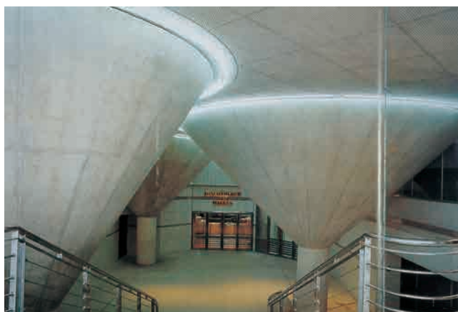
Paul Chemetov, les Halles, hall et couloir d'accès au métro, Paris, 1985.
