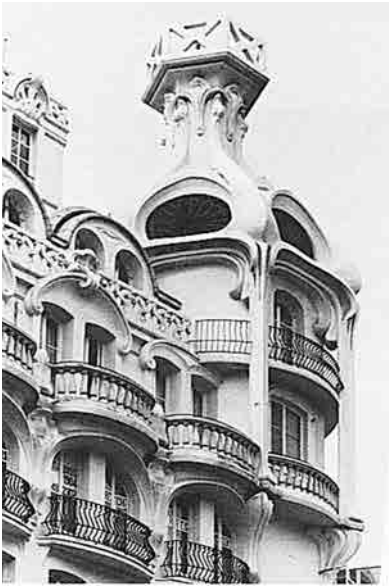
Paul Auscher, architecte, François Hennebique, constructeur. Magasin Félix-Potin, 140, rue de Rennes à Paris.
