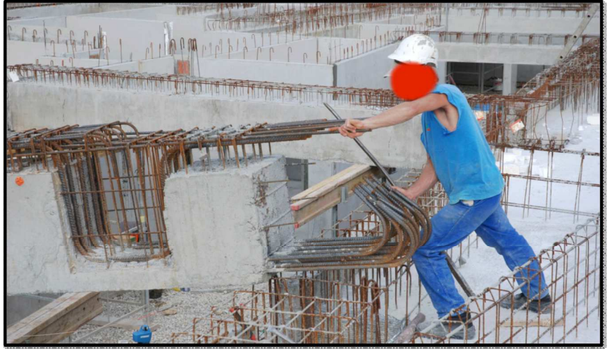
Illustration 3 : mise en place d'une retombée de poutre préfabriquée de masse 3,5 tonnes
